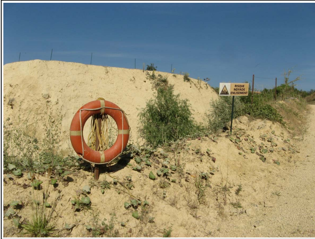
Signalisation, bouée, clôture ou merlon mis en place autour d'un bassin d'infiltration des eaux de ruissellement.
